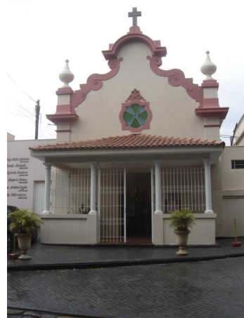
Foto: Fachada Frontal Fonte: Rede de Cooperação Identidades Culturais
