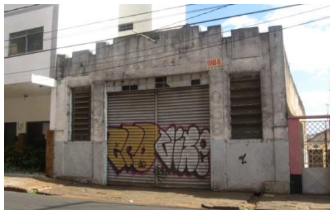
Foto 14: Galpão comercial com data na platibanda. Localização: Rua Saldanha Marinho, 1058. Foto: Rede de Cooperação, 2011.
