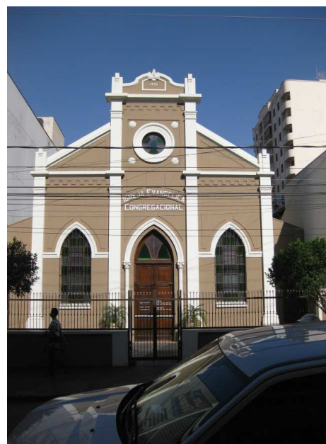
Foto: Fachada Frontal Fonte: Rede de Cooperação Identidades Culturais
