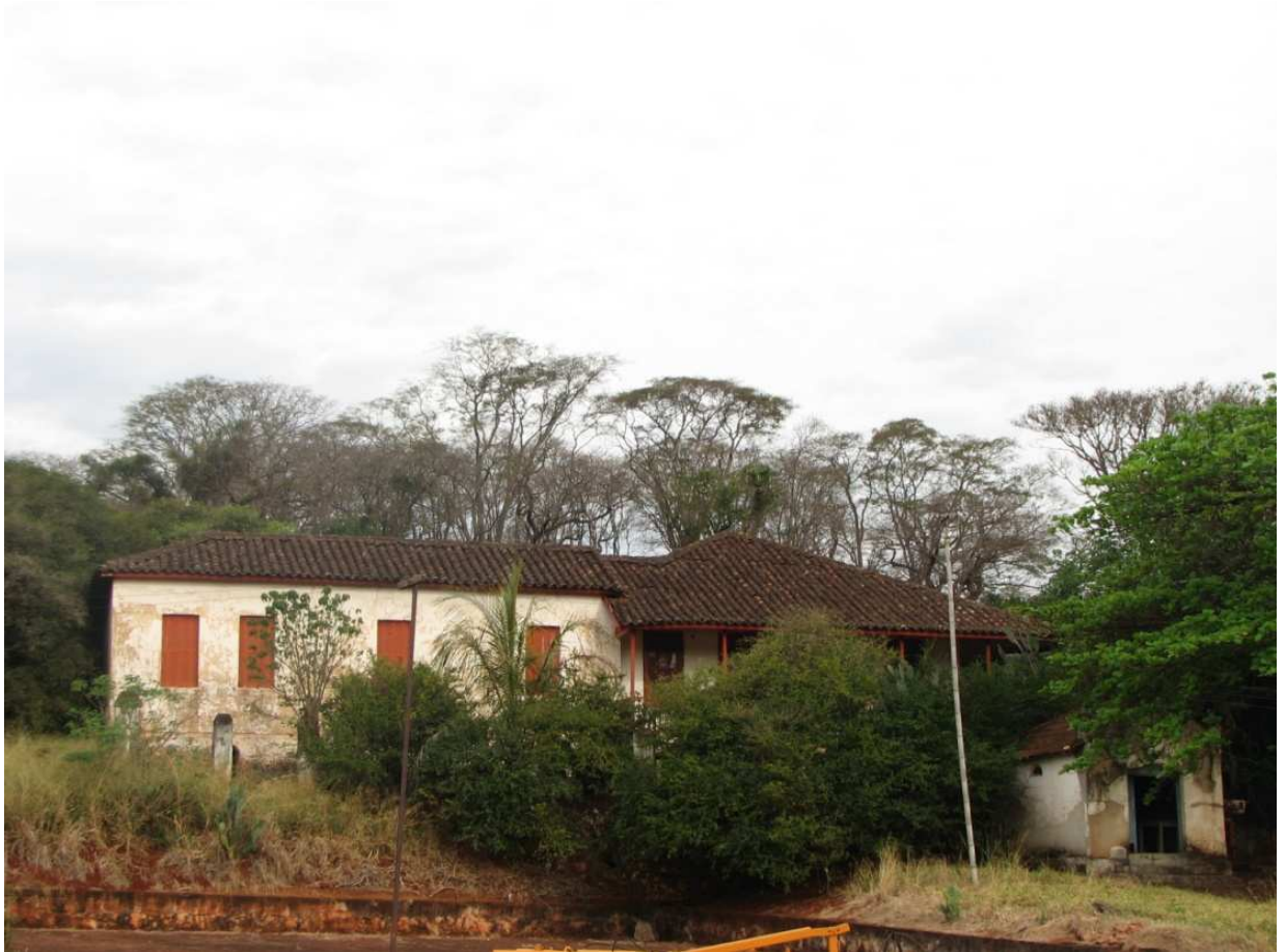
Foto: Apesar de estar mal conservada a Casa-Sede da Fazenda Sant'Ana ainda está bem preservada quanto as suas características originais . Fonte: Rede de Cooperação Identidades Culturais, 2011
