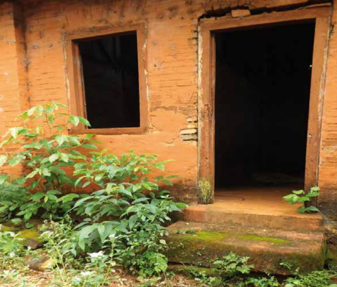
Foto 23 - Fachada de uma das casas de Colonos da Fazenda Boa Vista do Quinzinho - 2012.
